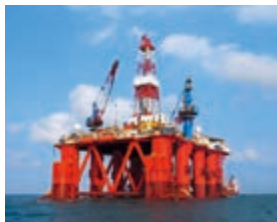
日本海洋掘削株式会社のセミサブ型リグ
